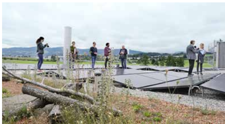
Auf dem Dach der neuen Anlage befindet sich eine 1400 Quadratmeter grosse Photovoltaik-Anlage. Daneben werden unbebaute Flächen naturnah bepflanz. Diese kleinen Biotope findet man überall auf dem Gelände der ARA.
